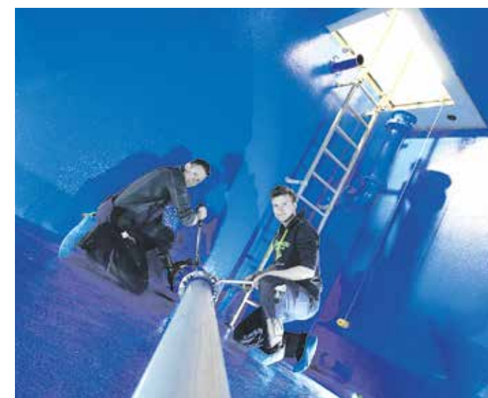
Vier Wochen dauerte die Sanierung der Wasserkammer im Hochbehälter in Wildenau. ESM-Mitarbeiter befestigen die letzten Schrauben an der Entnahmeleitung bevor die Kammer nochmals gereinigt und dann wieder geflutet wird. Nach der Beprobung des zugeführten Trinkwassers, werden die Haushalte dann wieder aus der Wasserkammer versorgt. (Foto: ESM; Stefan Rosenbaum)
