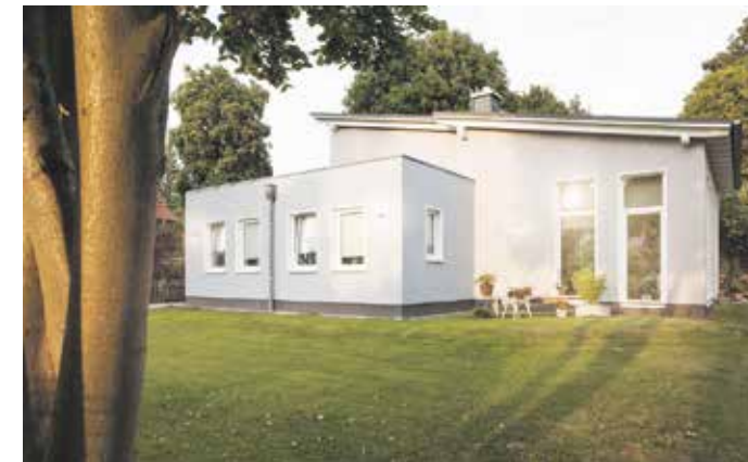
Erst kleiner bauen, später bei Bedarf erweitern: So können Bauherren die Kosten fürs Eigenheim zunächst niedriger halten. Foto: DJD/Bauherren-Schutzbund/Getty Images/Florian Küttler
